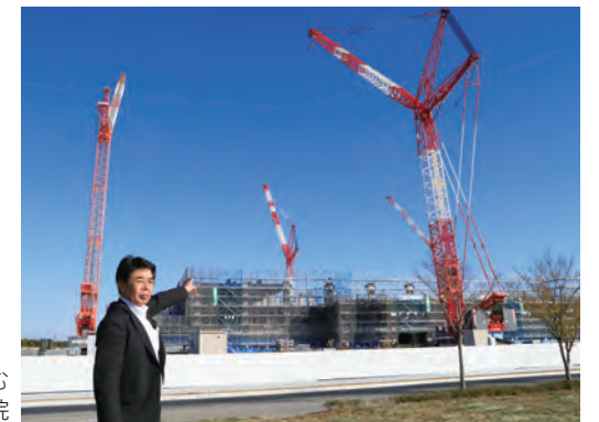
建設が進む 新協同病院
